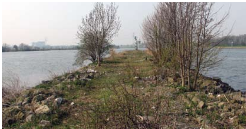
Beeld van strekdam ten westen van het stuweiland van Linne waar in het voorjaar een grote kolonie Grauwe ganzen tussen de breuksteen broedt.
