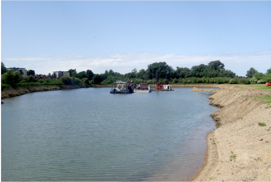
Graafwerkzaamheden in zomer van 2014.
