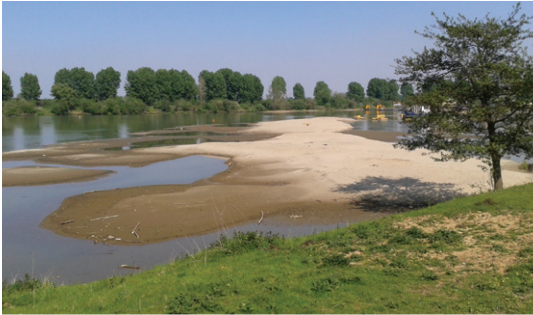
Ogespoten zandeilandjes in de Spoorplas: eerste aanzet voor nieuwe centrale dam.
