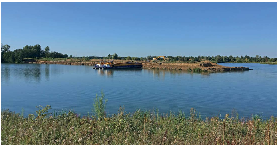
Afgraven oude centrale dam (augustus 2020).
