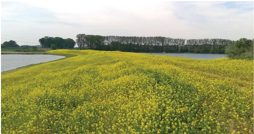
Voorjaarsbeeld van de nieuwe centrale dam (23 april 2019).
