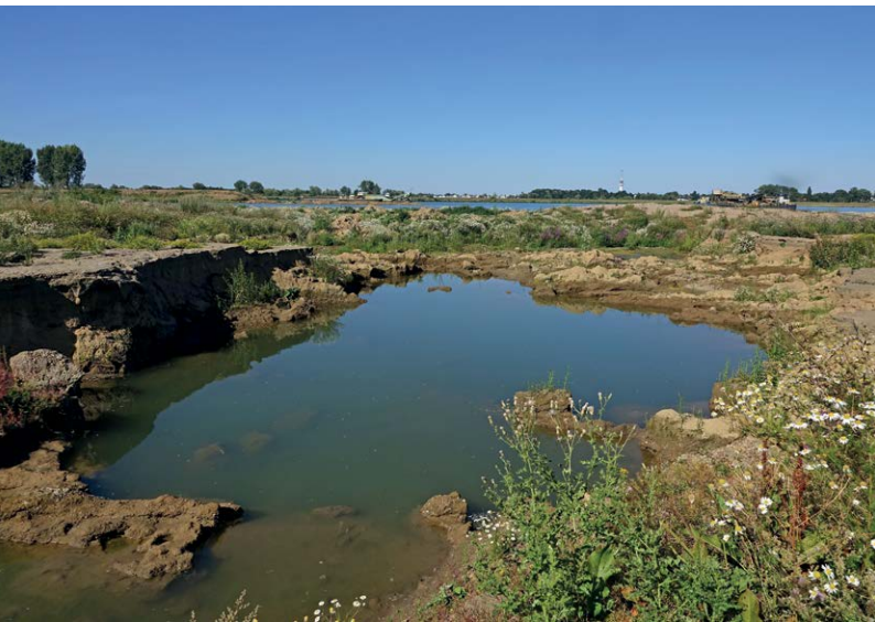
Erosie ter hoogte van instroom Maas richting voormalige Spoorplas (augustus 2020).
